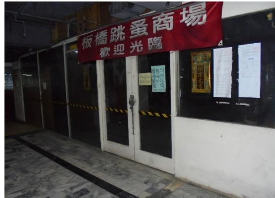
▲板橋區「金扶輪廣場大廈」地下1樓商場
