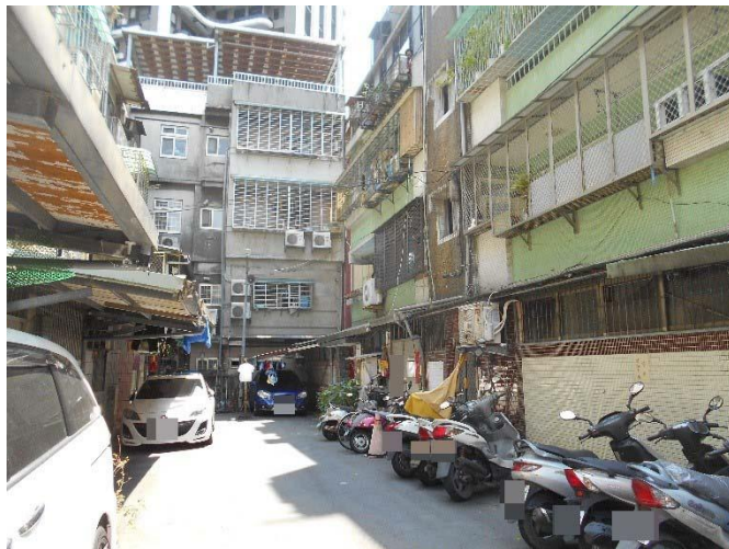
←新北市中和區德光段 83 地號土地(即中和區 民生街 12 巷)約 143 坪。
