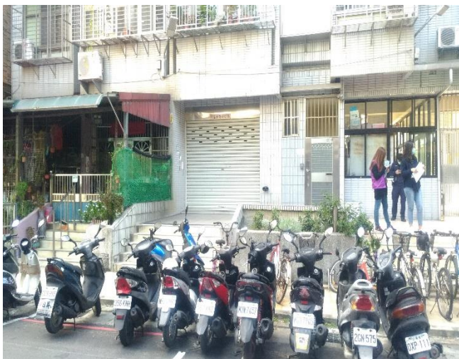
↑(左圖)蘆洲區三民路 26 巷 36 號 1 樓之建物
