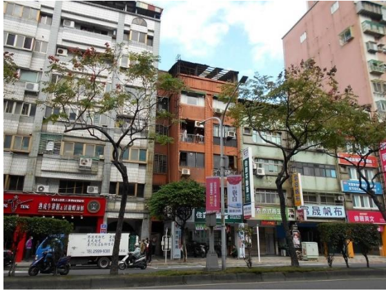
←三重區重陽路 3 段 134 號 5 樓及頂樓增建物外觀 (褐色)。
