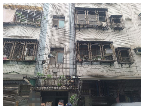
▲樹林區新興街公寓外觀
