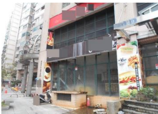
▲新莊區 1 樓挑高店面外觀
