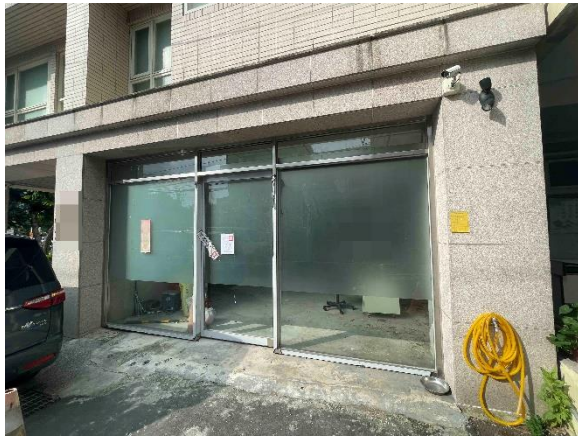
▲土城區 1 樓店鋪外觀
